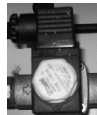
Zawór elektromagnetyczny
