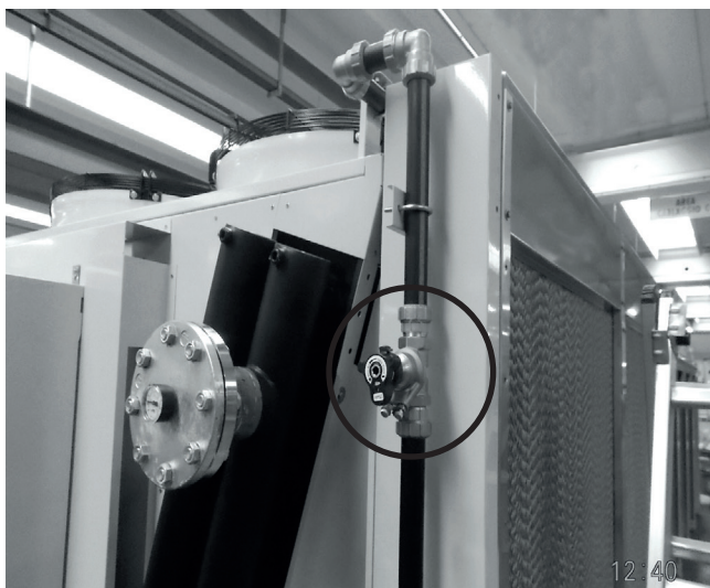
Деталь ручного балансировочного клапана
